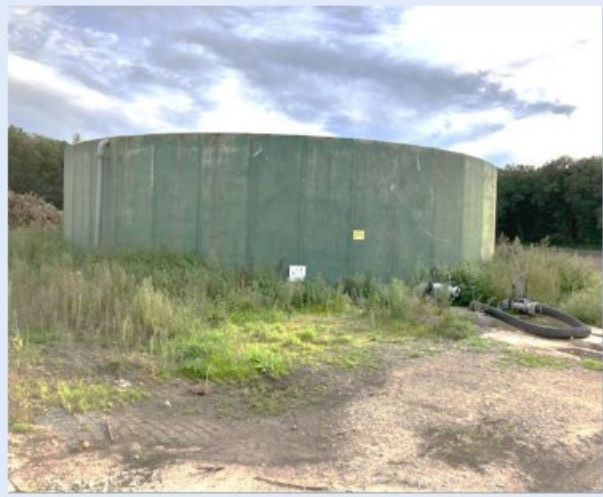
Foto 6: Mestbassin met recht de aansluitvoorziening voor het vullen en lossen van het bassin.
